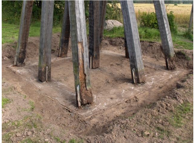
Bild 4. Fundamentet är frilagt.
