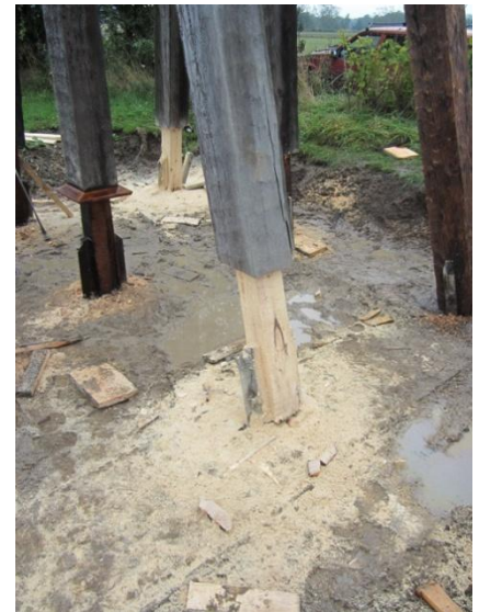
Bild 5. Främre benet renhugget intill kärnviket. Hjärtstocken behandlad med trätjära.
