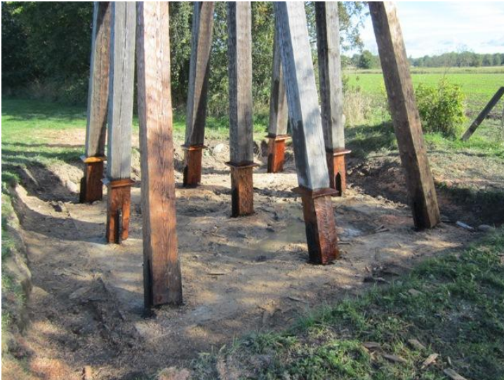
Bild.7. Två helt nya ben, sju holkar. Återstår påfyllnad av kullersten.
