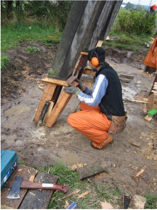
Bild 6. Holk tilpassas
