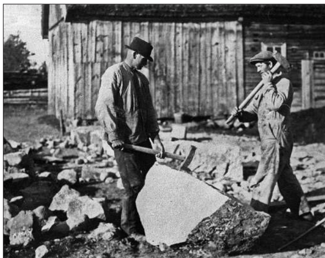
Ovan ses två män sätta av en sten. Troligen passar de in en grundsten och vill att fogen ska bli så tät som möjligt. Till höger ses samma män stolt visa upp husgrunden. Sörgården, Rörsås, Ullervads socken. Ullervad-Leksbergs Hembygdsförenings bildarkiv.
