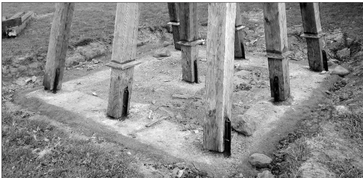
Two completely new legs, seven holks. Återstår påfyllnad av kullersten. Foto Truls Wiberg
