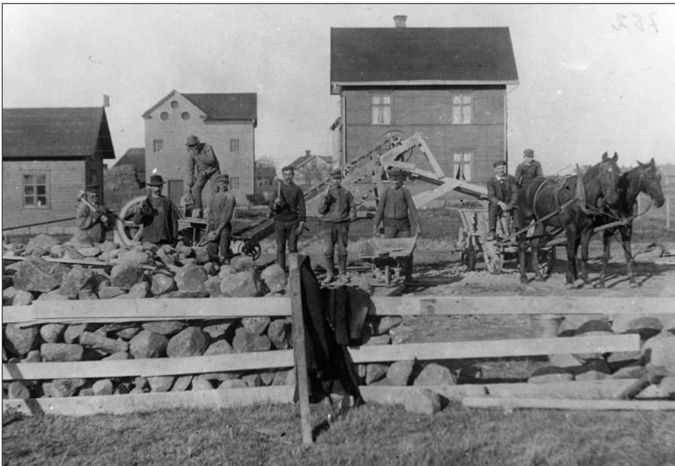
J. Melin? och okända vid arbete med stenkross. För- modligen används krossen till vägbyggen och större gjutningsarbeten. Foto: Erik Rud. Mariestads Bildarkiv/Stadsbiblioteket.
