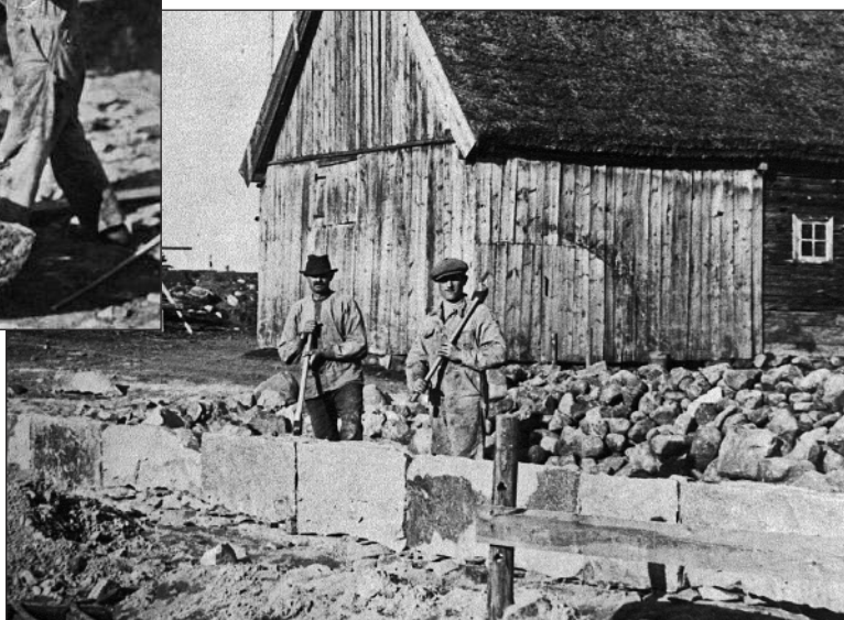
Ovan ses två män sätta av en sten. Troligen passar de in en grundsten och vill att fogen ska bli så tät som möjligt. Till höger ses samma män stolt visa upp husgrunden. Sörgården, Rörsås, Ullervads socken. Ullervad-Leksbergs Hembygdsförenings bildarkiv.
